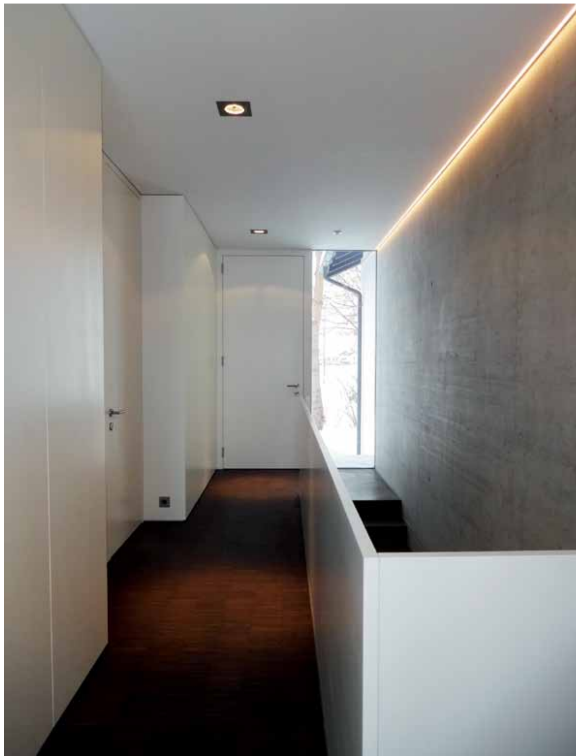
Versteckte Lichtleisten zwischen Wand und Decke sorgen für die Grundbeleuchtung.
